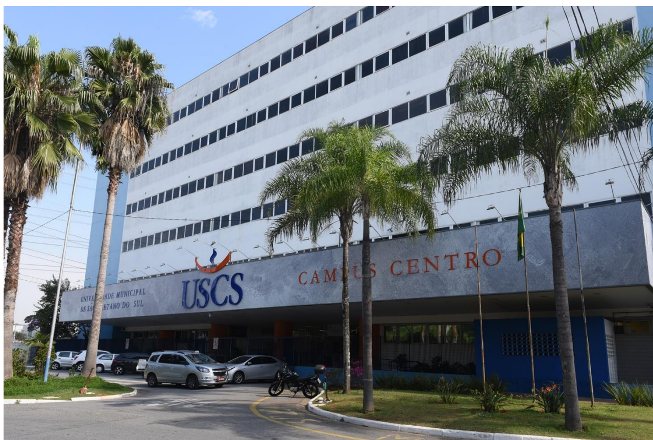
Fachada do Campus Centro da USCS.
